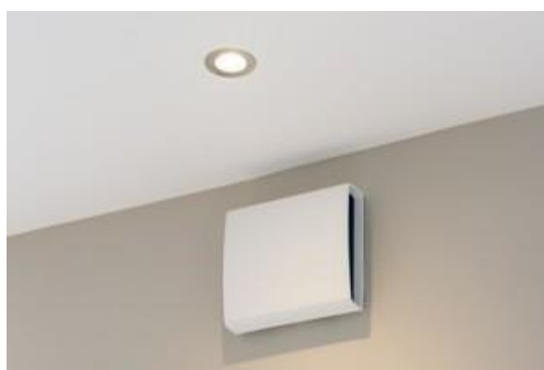
Prikaz vgrajene lokalne rekuperacijske naprave.
